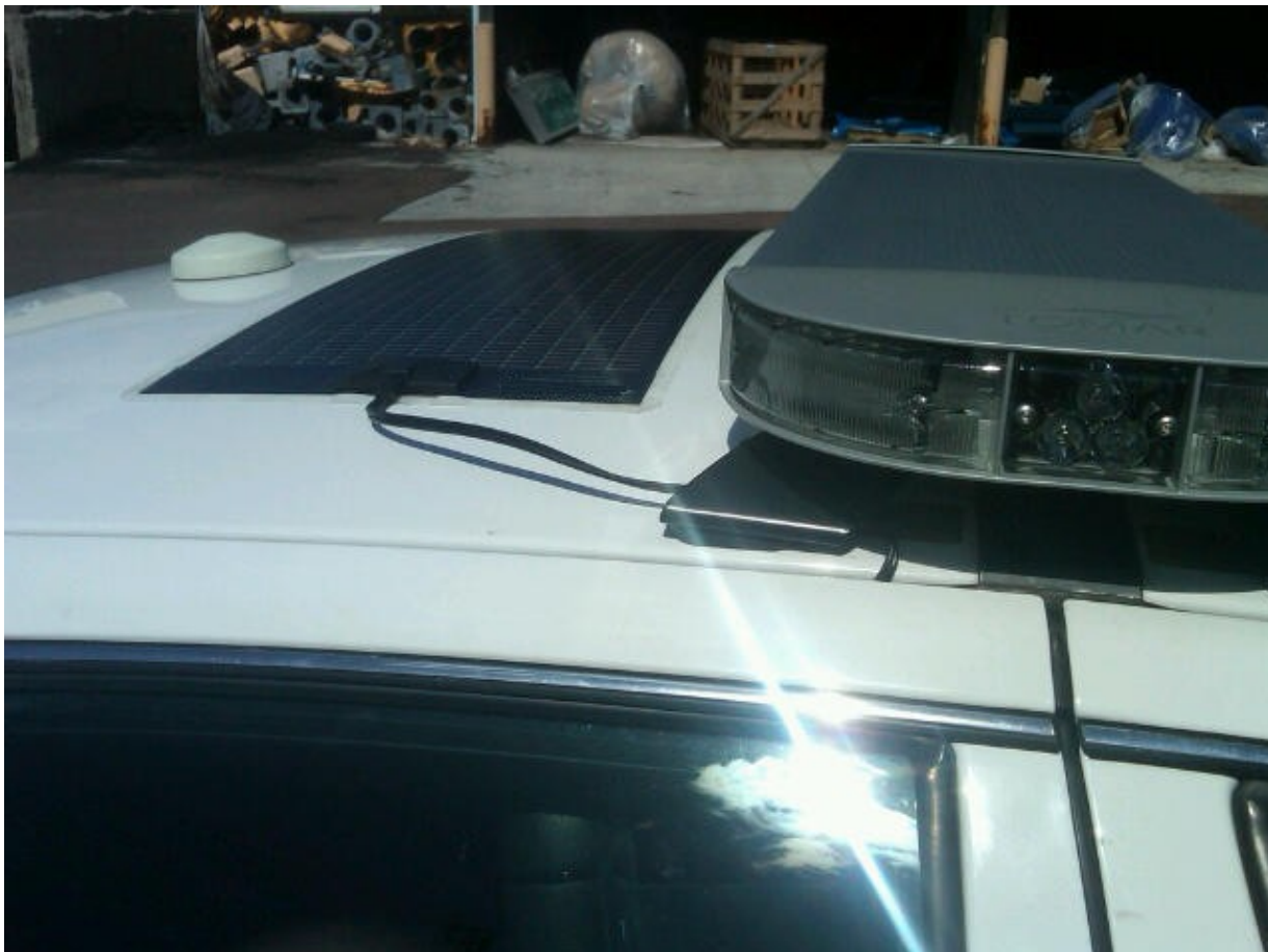
Figure 1. Installation sur un véhicule ancien
